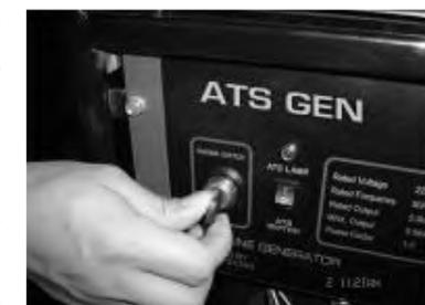
Когда произойдет остановка подачи электропитания из основной сети, встроенная система ATS автоматически запустит генератор, и он начнет подавать напряжение на подключенные к нему устройства. Когда возобновится подача напряжения из основной электросети, встроенная система ATS выключит генератор и напряжение пойдет снова к потребителям напрямую из основной сети.
